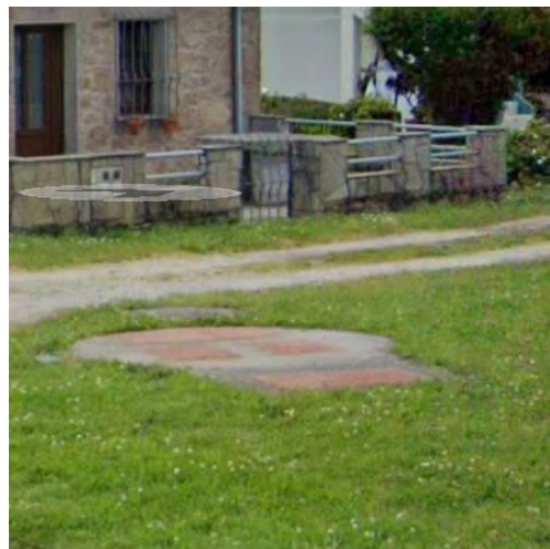
Figura 29: Imaxe do elemento singular EBAR MARÍTIMO
