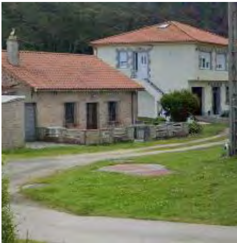
Figura 28: Imaxe do elemento singular EBAR MARÍTIMO
