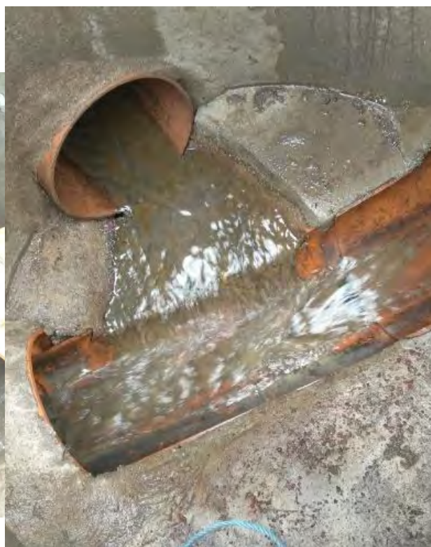
Figura 52: Pozo con biofilm medio (colector lonxitudinal) e alto (aportación superior)
